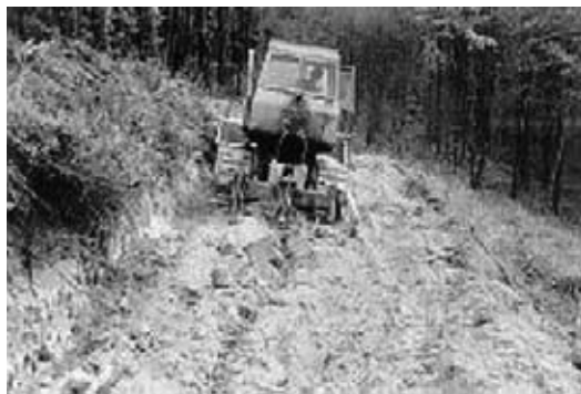
Slika 119. Ješevac – Riperovanje dela terase u zaseku
