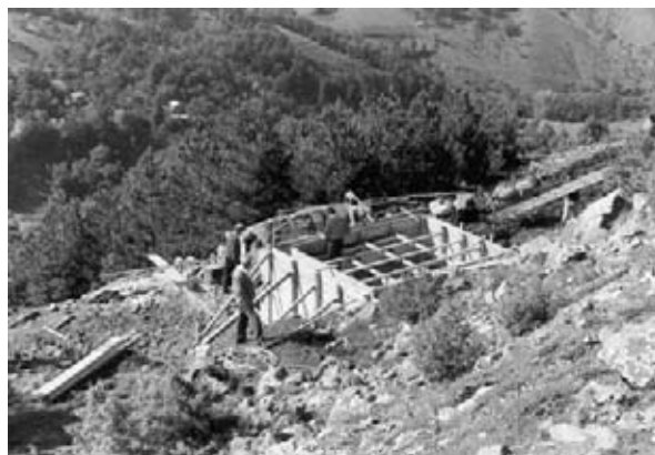
Slika 173. Izgradnja rezervoara za vodu – Gokčanica
