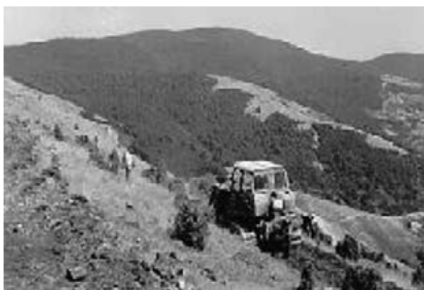
Slika 123. Ogledno polje 8 Lokalitet Gokčanica – Izrada terasa za pošumljavanje dozerom TG-100
