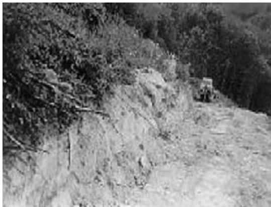
Slika 118. Ješevac – Izrada terasa dozerom TG-100
