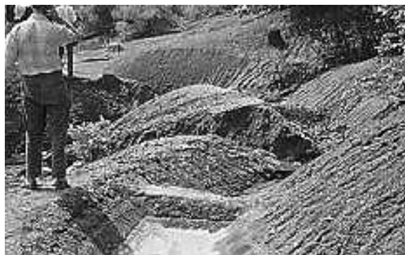
Slika 84. Konturni rov sa ekvilizerom (Deo u kojem je probijen nasip. Voda je istekla samo sa tog dela)
