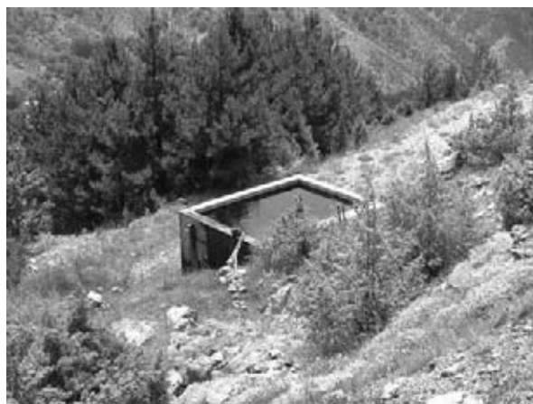
Slika 174. Izgrađeni rezervoar za vodu – Gokčanica
