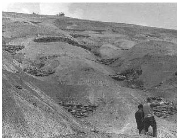
Slika 90. Pleteri u vododelnici
