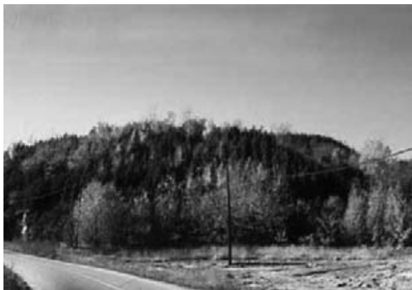
Slika 137. Odlagalište jalovine – "kipa" obrasla šumskom vegetacijom antropogeno osnovanom u postupku biološke rekultivacije
