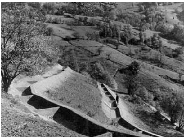
Slika 80. Konturni rovovi na Randelovcu – Grdelička klisura
