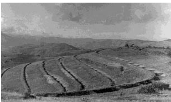
Slika 81. Konturni rovovi na Sejmenskoj bukvi – Grdelička klisura
